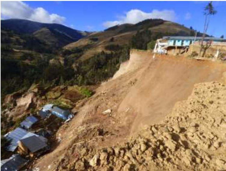
Fotografía 5. Se aprecia parte del escarpe principal y viviendas que se desplomaron por el deslizamiento.
