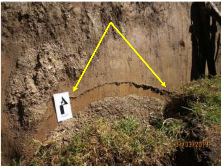
Fotografía 10. Marca en la pared del escarpe en formación, señala el desplazamiento reciente que ha tenido el terreno (señalado con línea amarilla).
