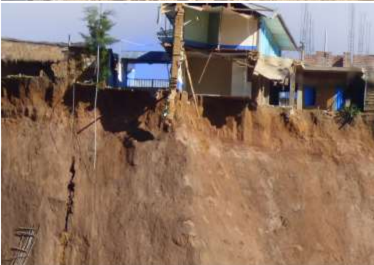
Fotografía 6. Vista frontal donde se aprecia el escarpe principal con desplazamiento recto. Además, viviendas semidestruídas.
